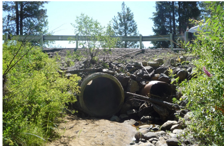
N.F. Teanaway Rd existing culverts
